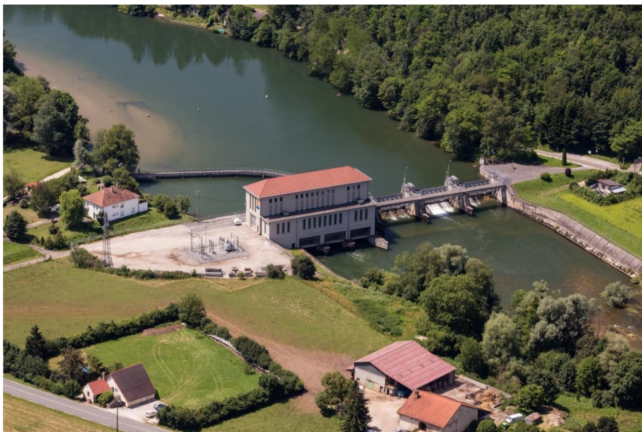
Centrale hydroélectrique de Dampjoux - ©PMA Tim Platt
