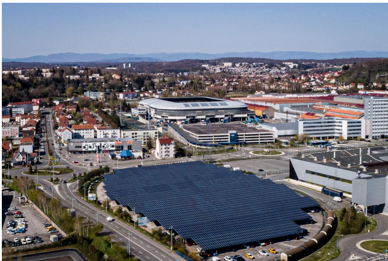
Ombrières photovoltaïques de Stellantis à Montbéliard © Samuel Coulon
