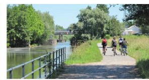
Le canal Rhin-Rhône en aval du pont Ludwigsburg (ADU, 2016)
