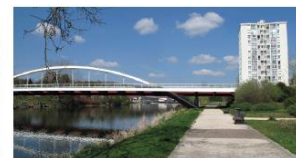
Le Doubs à Audincourt, pont Bollardière (ADU, 2014)
