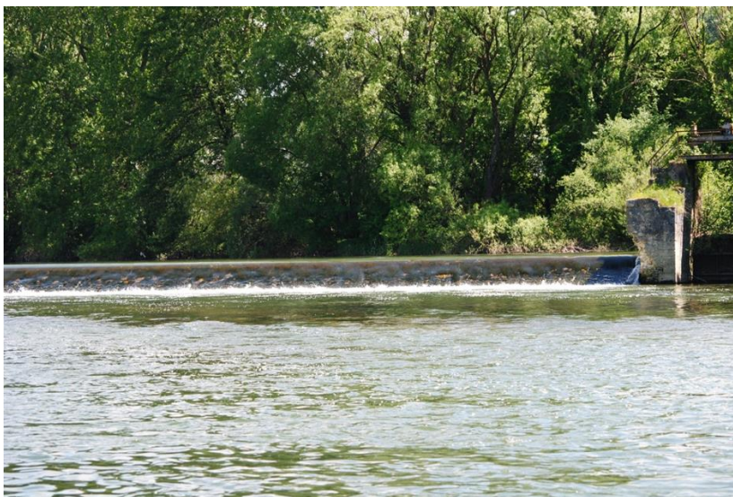
Exemple de seuil difficilement franchissable du Doubs. Source : Thomas Déforêt – BCD Environnement
