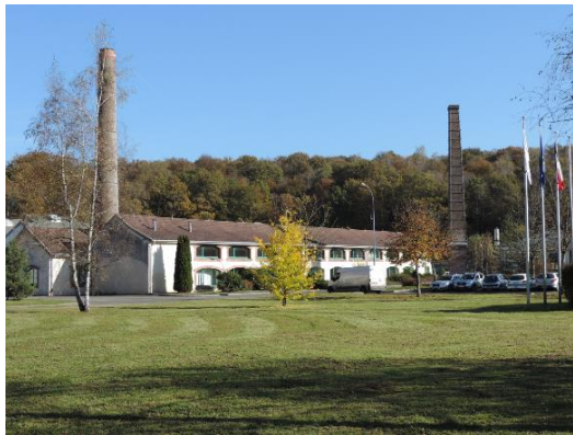
Fesches-le-Châtel – usine Cristel réhabilitée et modernisée
