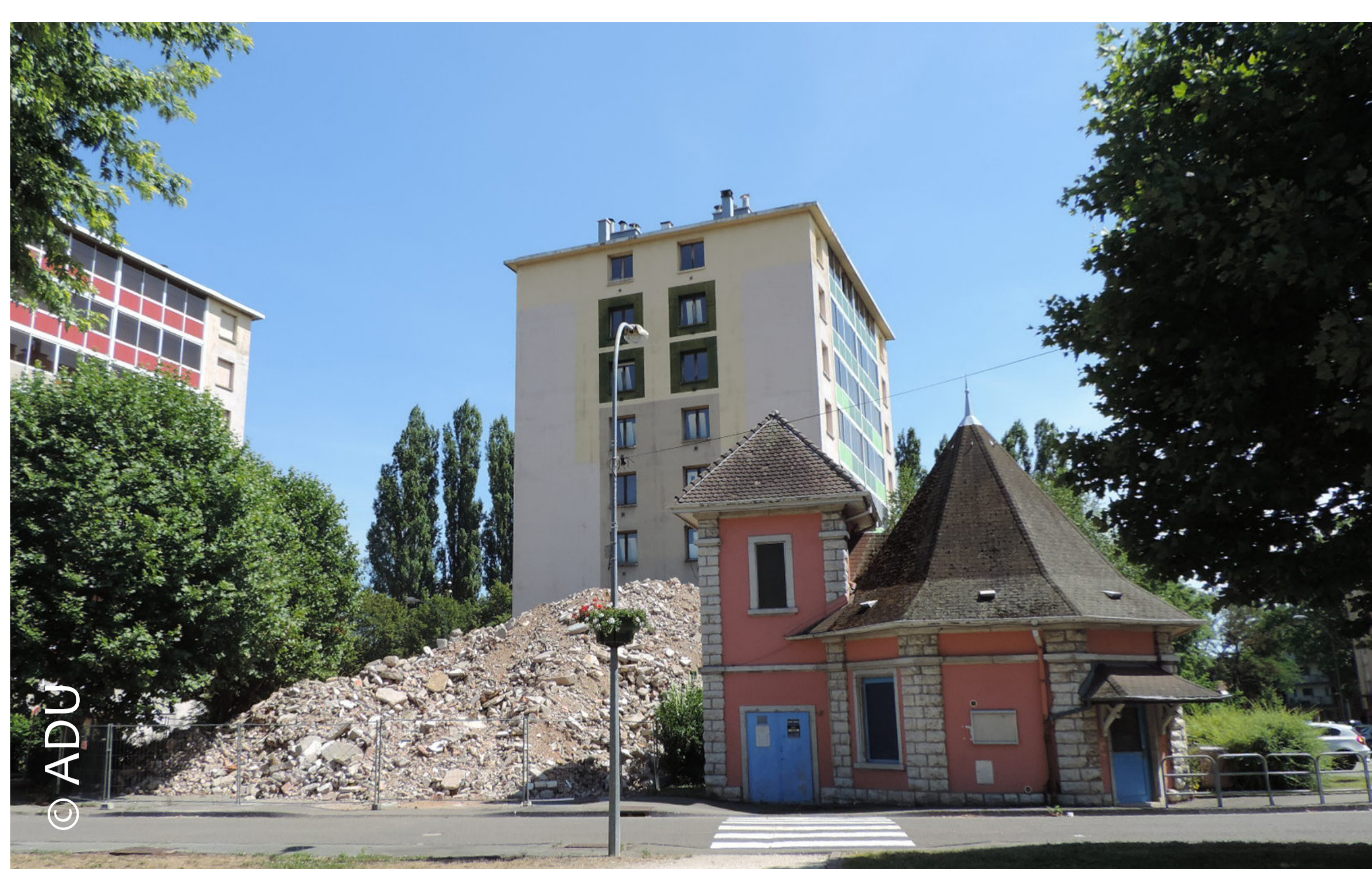
La maison du projet et les démolitions
