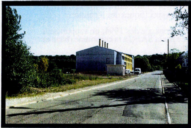
● La chaufferie centrale
